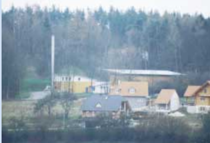
Blick in das Neubaugebiet „Am Hahn“, an dessen Rand das Holzheizwerk steht.
