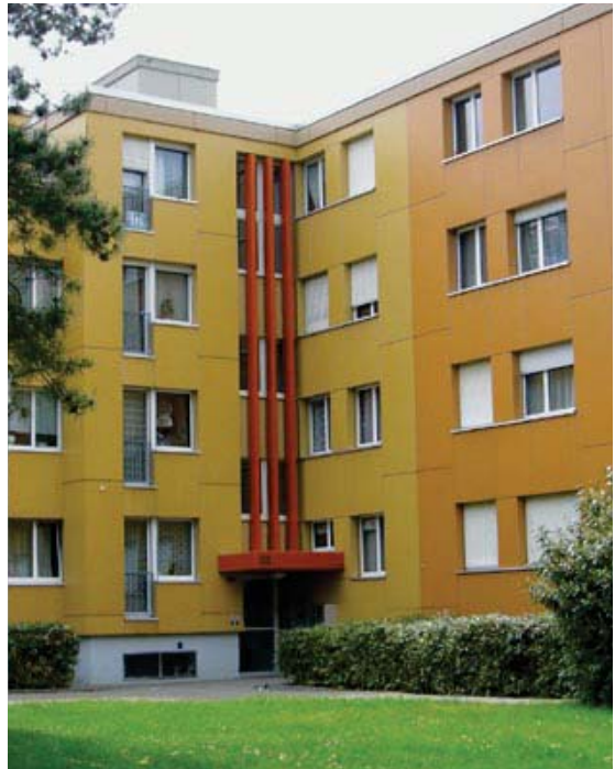
Die Fassade im neuen Anstrich
