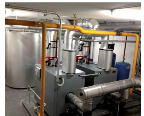
Die Heizung der Siedlung Otto-/Josefstrasse (links) wurde durch eine Gasheizkesselanlage ersetzt.
