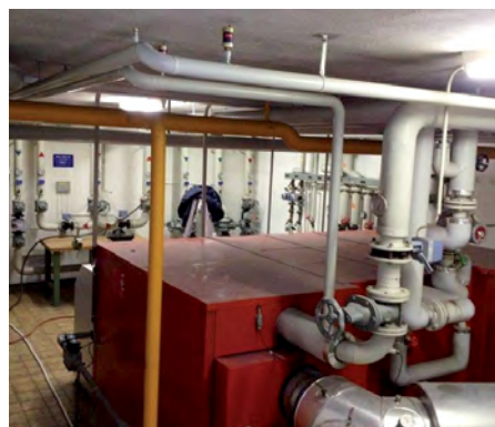
Die Heizung der Siedlung Otto-/Josefstrasse (links) wurde durch eine Gasheizkesselanlage ersetzt.
