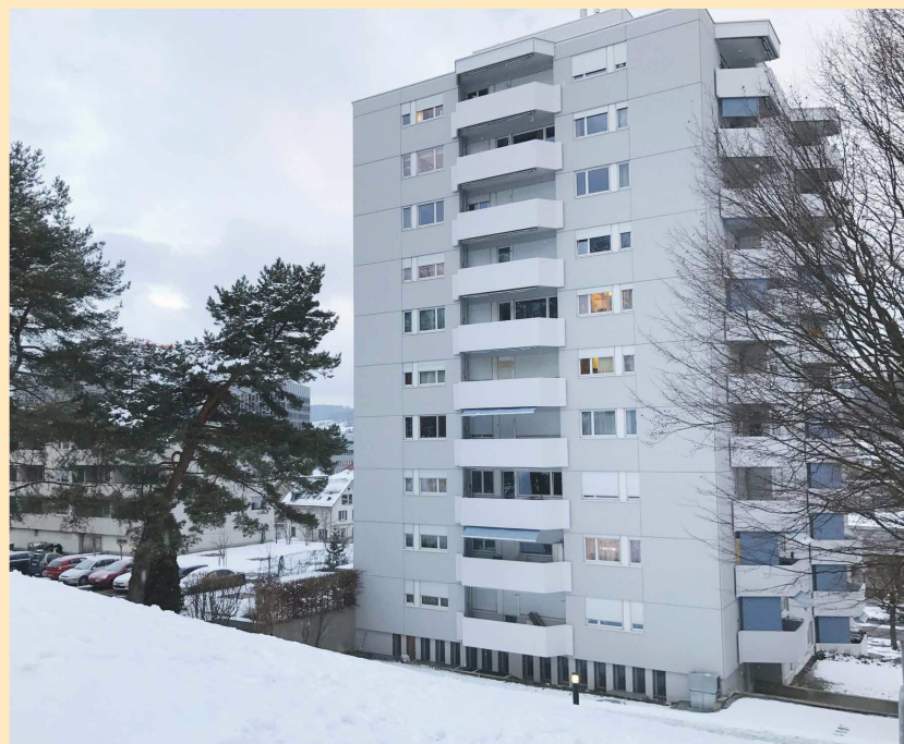
Liegenschaft an der Schulstrasse 68 in Schlieren
