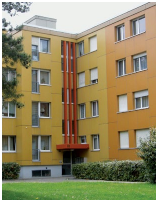
Die Fassade im neuen Anstrich
