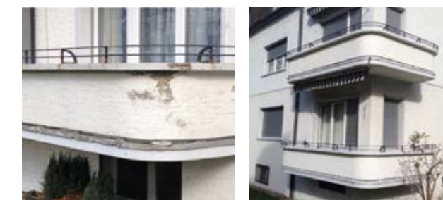
Balkone der Siedlung 23 vor und nach der Sanierung
