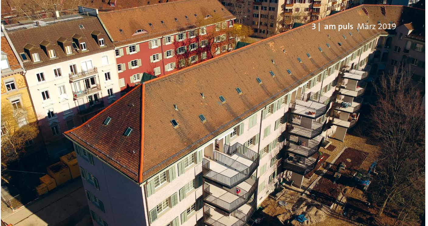
In der Siedlung Josefstrasse 161–167 wurden die Balkone neu gemacht.
